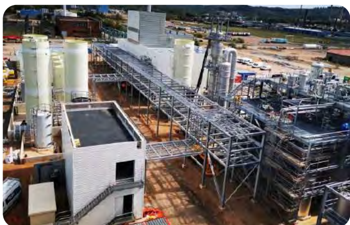
Gestion de projet global avec montage de structures métalliques et racks
