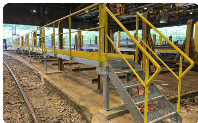
Passerelle métallique avec garde corps
