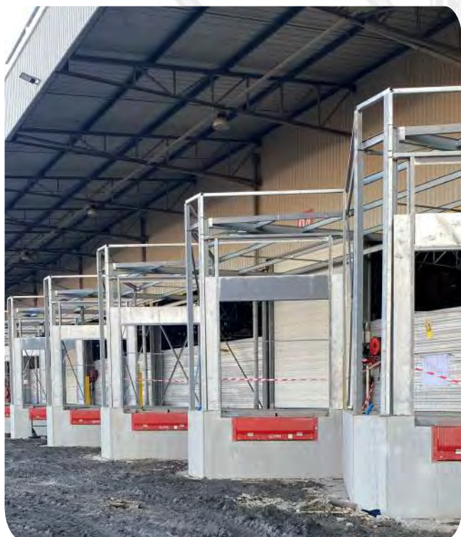
Structure de quais de déchargement
